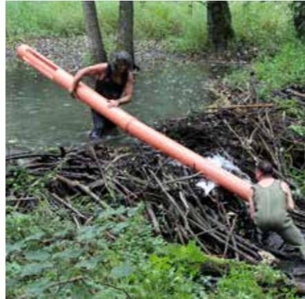
Mitarbeiter beim Einbau eines Drainagerohres
