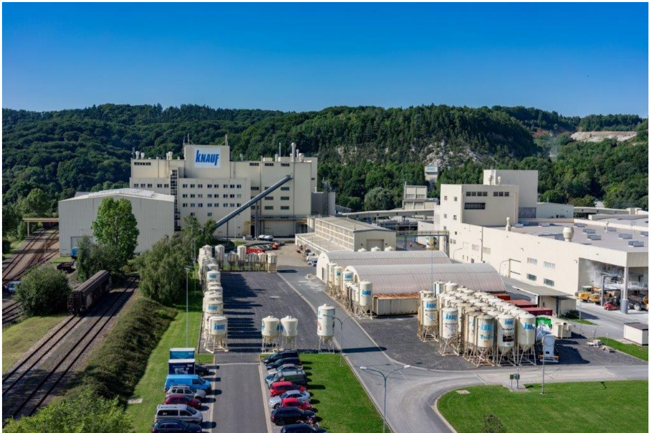
Knauf Gipswerk in Rottleberode Quelle: Knauf Gips KG
